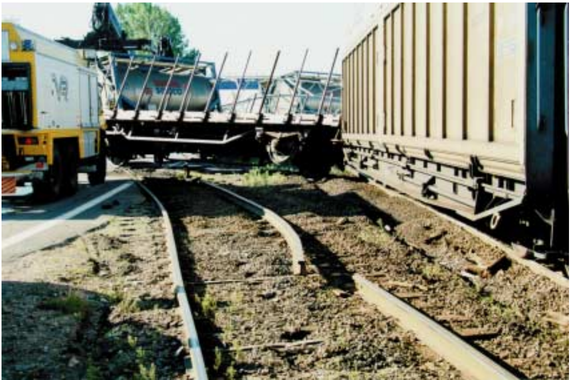
Kuva 5. Kemikaalivaunun suistuminen raiteilta Helsingin Länsisatamassa 5.9.1998. Vaurioitunutta raidetta 372.
