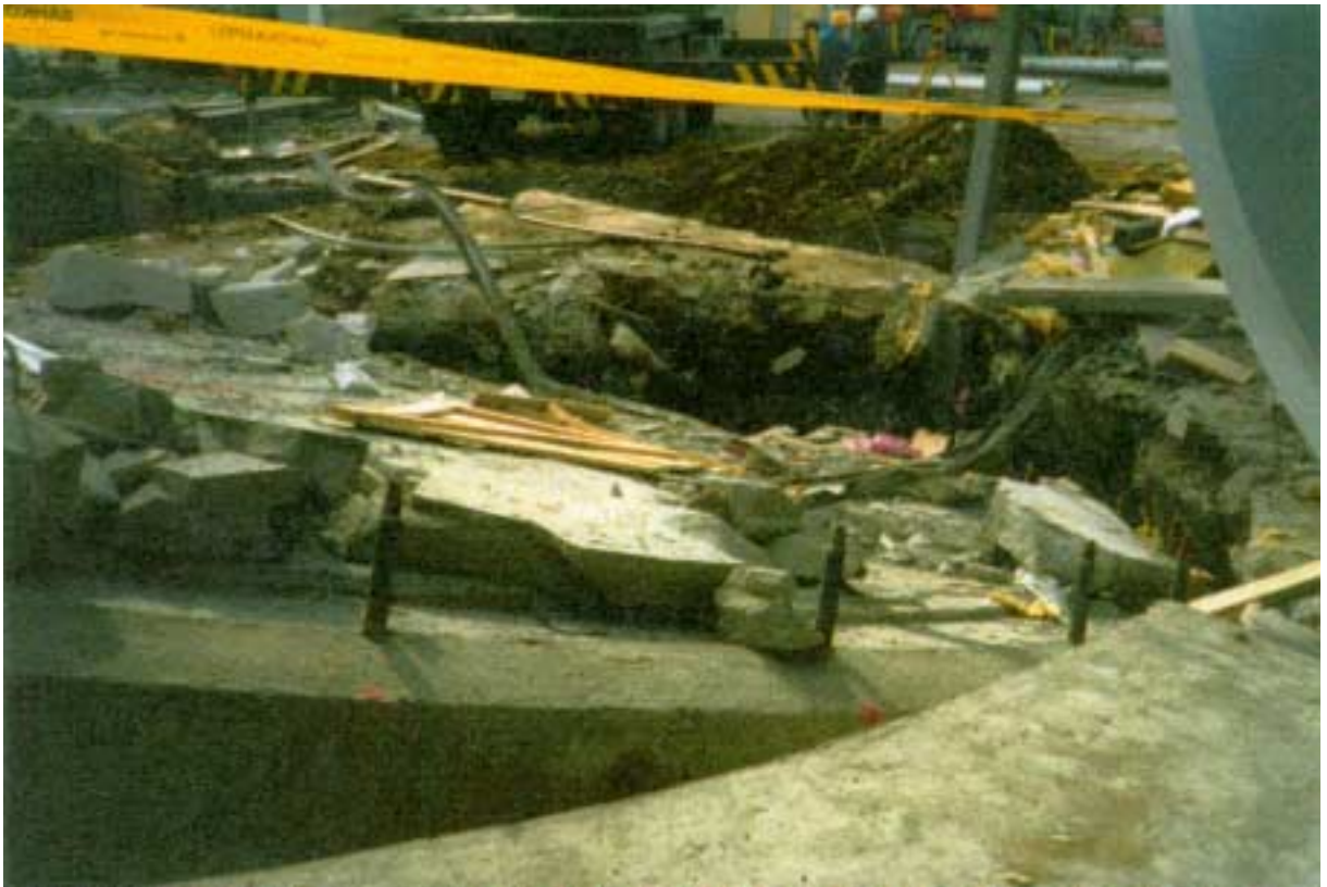
Kuva 4.1.3D Peruslaatan ympyränmuotoinen keskiosa, joka on leikkautunut ja kallistunut voimakkaasti säiliön kaatumissuuntaan.
