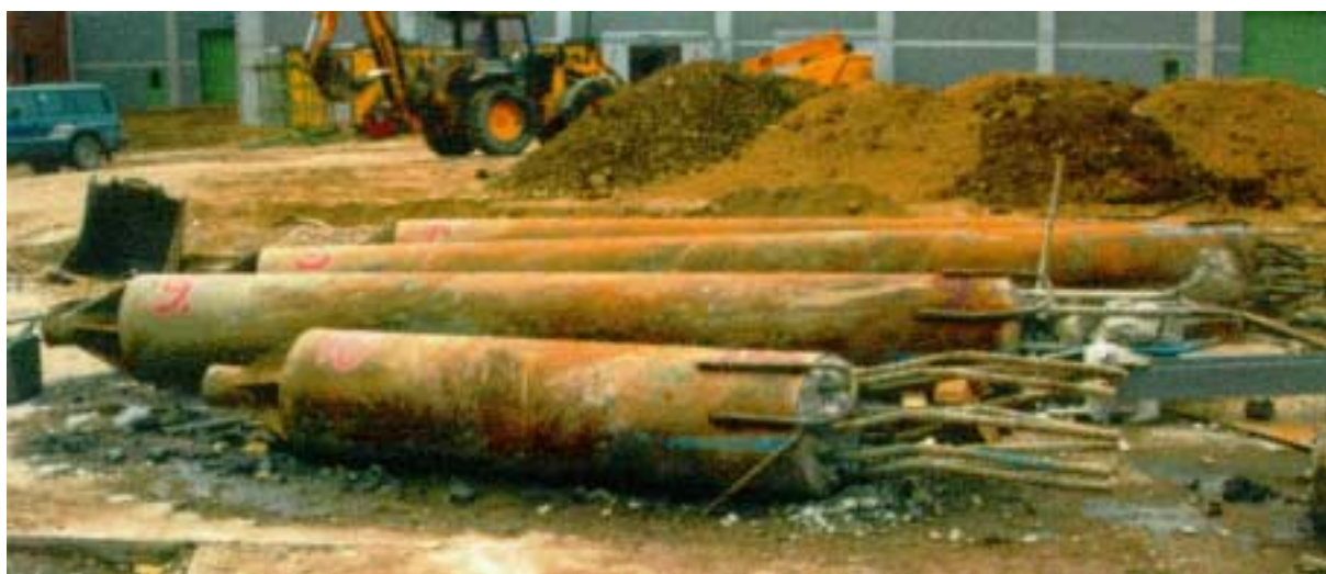
Kuva 4.1.2B Maasta ylösnostettuja teräsputki-paaluja. Edessä paalu nro 10.
